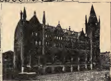
FACHADA DE LA ESTACION.
